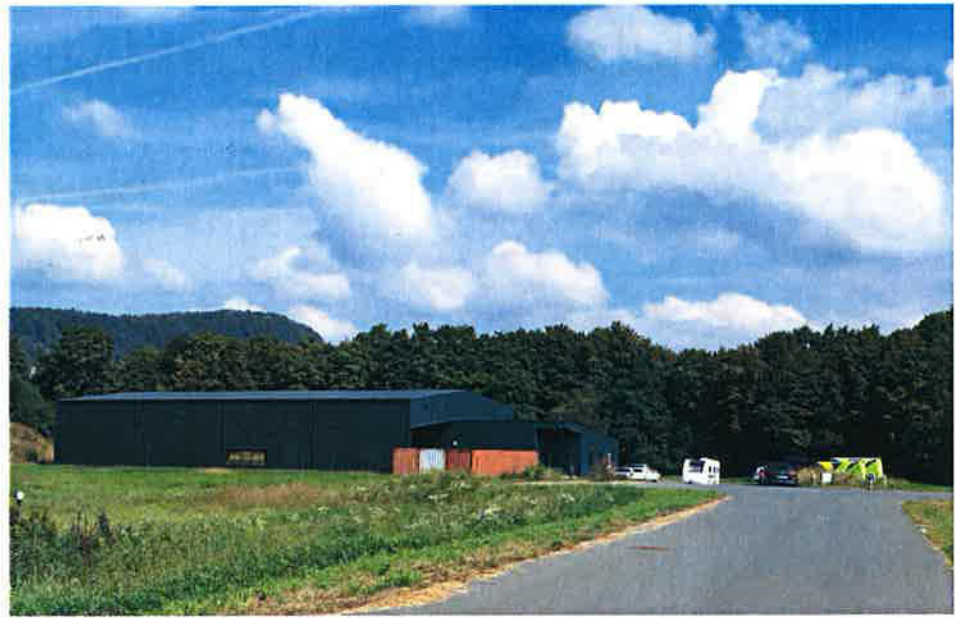
Gewerbestraße Jöb-Nord, Blickrichtung Nordosten mit dem bestehenden Betriebsgebäude auf dem Grundstück 183/6 der KG Jöb in der linken Bildhälfte.
