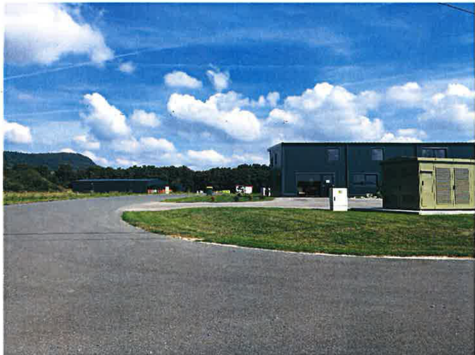
Einfahrt Gewerbestraße Jöß-Nord, Blickrichtung Nordost mit den zwischenzeitlich errichteten Betriebsgebäude.
