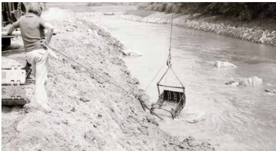
Ausbaggern des Flussbettes und Errichtung einer steinernen Böschung (Quelle: UMJ, Ortsakten).
