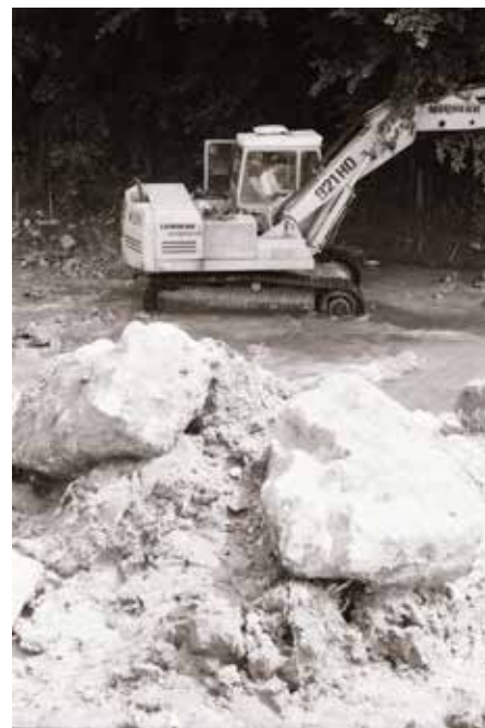
Baggerarbeiten im Flussbett der Laßnitz (Quelle: UMJ, Ortsakten).
